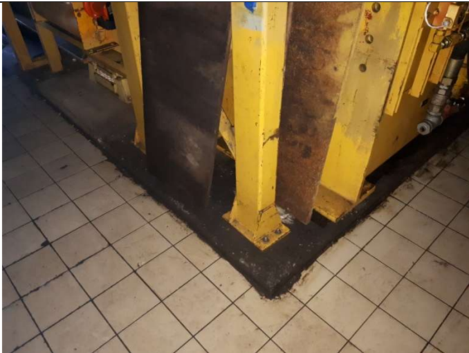
Photographie 19 : Support béton souillé aux hydrocarbures Source : Prise de vue DEKRA
