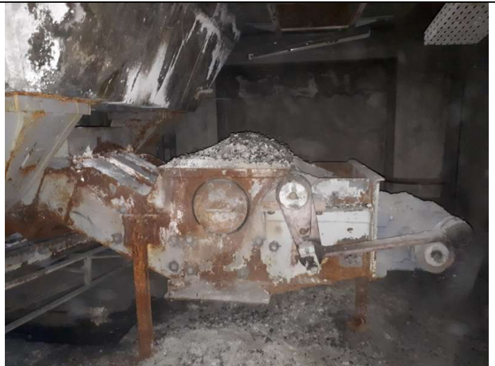
Photographie 13 : Convoyeur/extracteur de cendres Source : Prise de vue DEKRA
